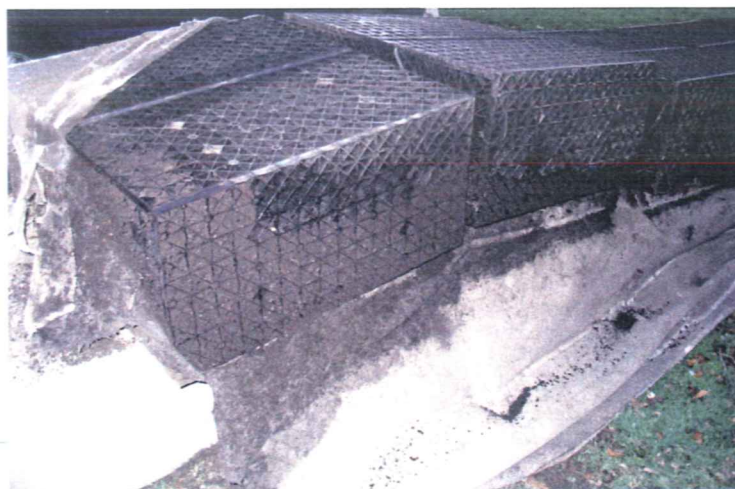
Infiltratie voorziening zonder voorzuiivering
